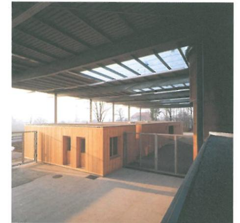
Auf den Rahmenbindern aufgelegt sind die Pfetten aus IPE 160 Profilen. Dachhaut aus Sinus-Trapezblechen mit Antidröhn- und Kondensatschutz. Die Anlage wird mit einer 3 Meter hohen Lärcheholzwand- und Metallgittertoren umschlossen.
