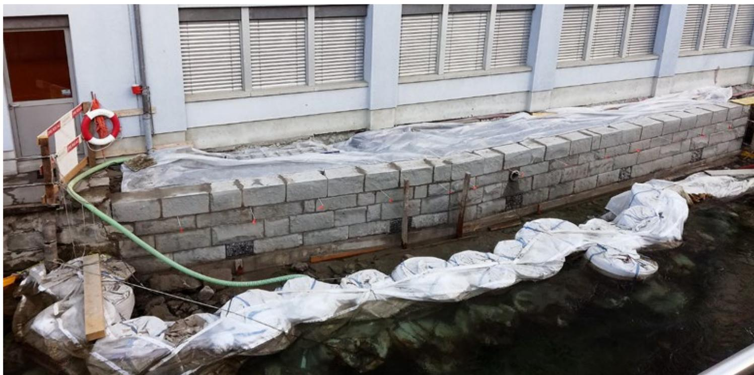
*Neuer Ufermauerabschnitt: Ein letzter Einblick in die neuen Nischen für Fische und Fledermäuse, bevor Wasserspiegel und Stegplatte sie schützend verdecken und so den schwimmenden und fliegenden Untermietern Schutz bieten.*
