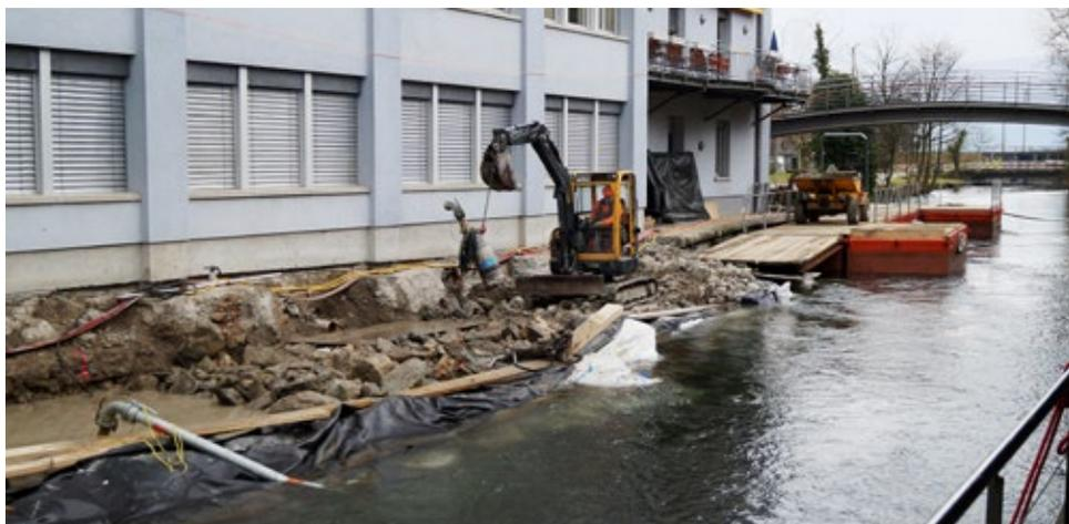
*Das Versetzen einer Pumpe mittels Bagger, um Gewässertrübungen während den Betonierarbeiten zu verhindern.*
