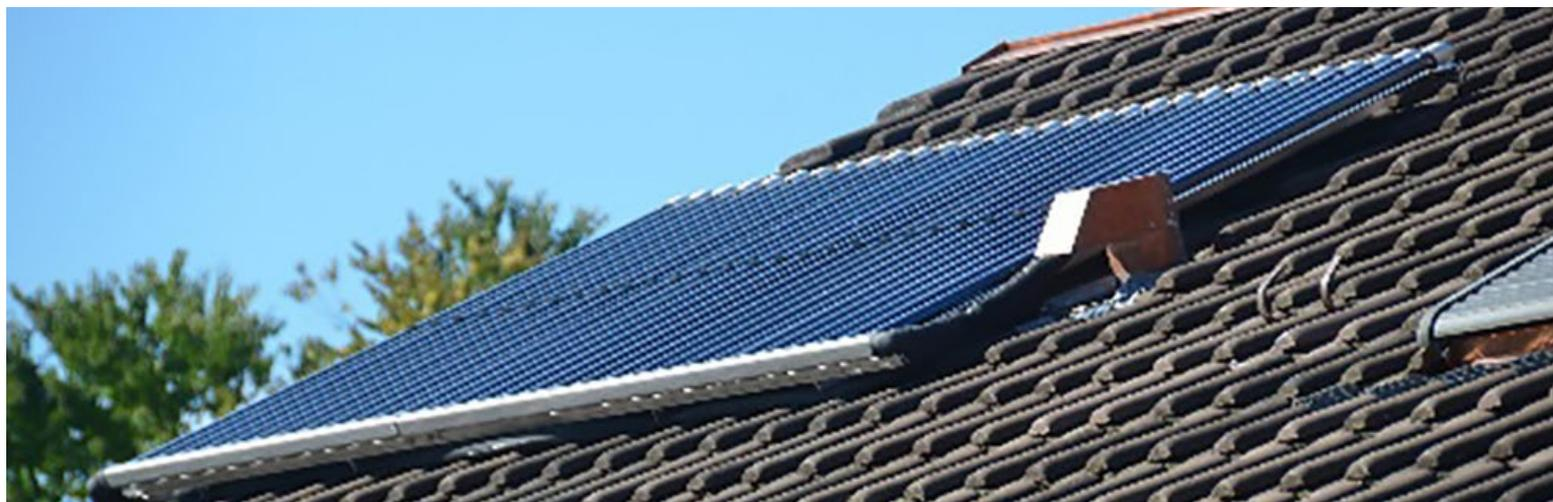
Viele Chamer Dächer eignen sich sehr gut für die Installation von Solaranlagen. Im Bild eine thermische Solaranlage für Warmwasser und Heizungsunterstützung.
