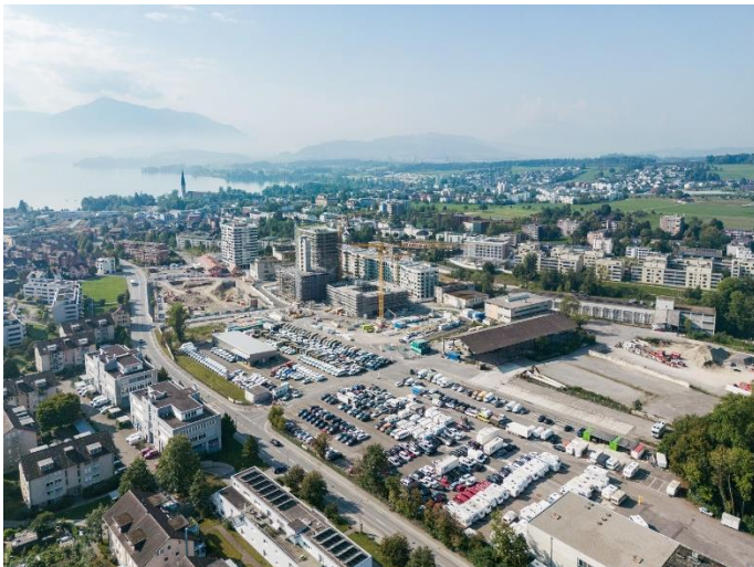
Luftaufnahme des Areals Pavatex Süd. (Bild: Cham Group, Beat Bühler)
