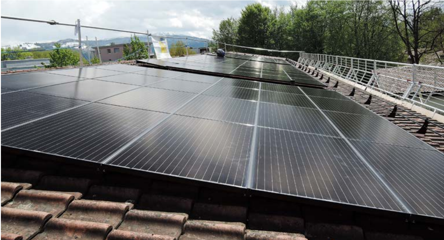
Photovoltaikanlagen – wie hier auf dem Schulhaus Städtli 1 – gehören mittlerweile zum Alltag.
