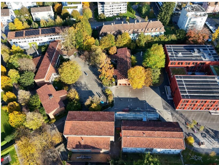
Die Gemeinde Cham treibt im Rahmen der Schulraumplanung auch die langfristige Entwicklung des Schulstandorts Städtli voran, hier im Bild die Schulhäuser Städtli 1 und Schürmatt. (Bild: Einwohnergemeinde Cham)
