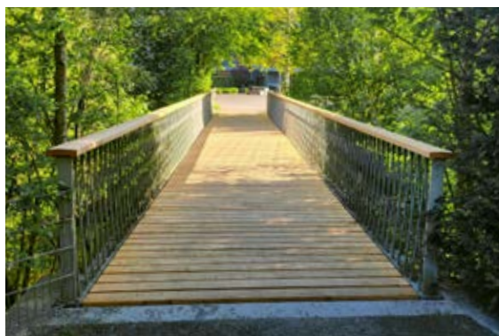
An der Brücke Grobenmoos wurde eine Antirutschbeschichtung aufgetragen.
