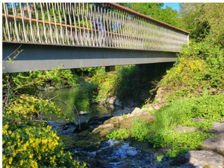
Die Brücke Furt Lorzenweg mit dem Nistkasten für Wasseramseln.
