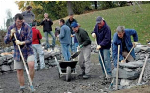
Bau Trockensteinmauer im Wohnquartier Röhrliberg
