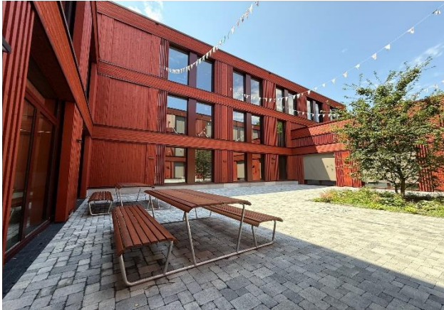
Blick in den Innenhof des Schulhauses Schürmatt.
