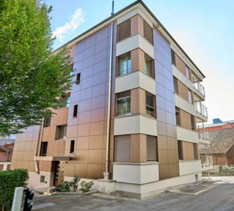
Solarmodule als Bestandteil der Fassadengestaltung an der Obermühlestrasse 7
