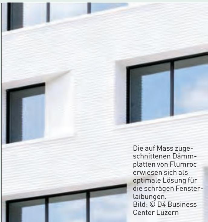
Die auf Mass zugeschnittenen Dämmplatten von Flumroc erwiesen sich als optimale Lösung für die schrägen Fensterläubungen.
