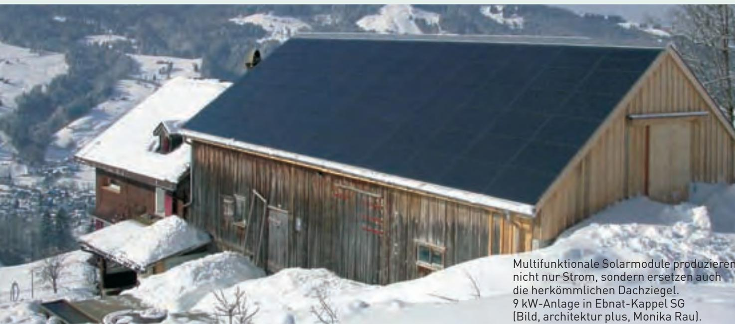
Multifunktionale Solarmodule produzieren nicht nur Strom, sondern ersetzen auch die herkömmlichen Dachziegel. 9 kW-Anlage in Ebnet-Kappel SG (Bild, architektur plus, Monika Rau).
