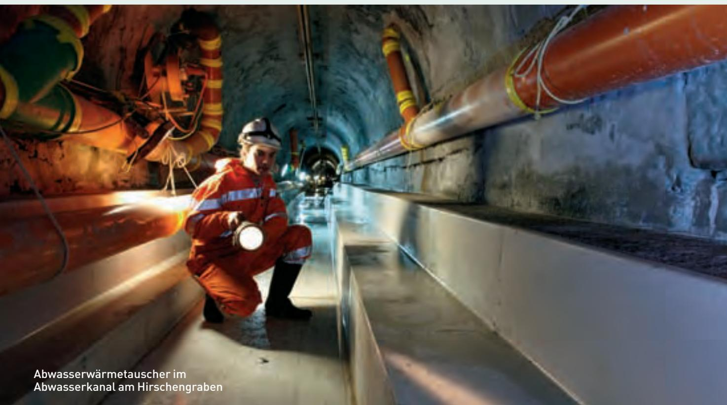
Abwasserwärmetauscher im Abwasserkanal am Hirschengraben
