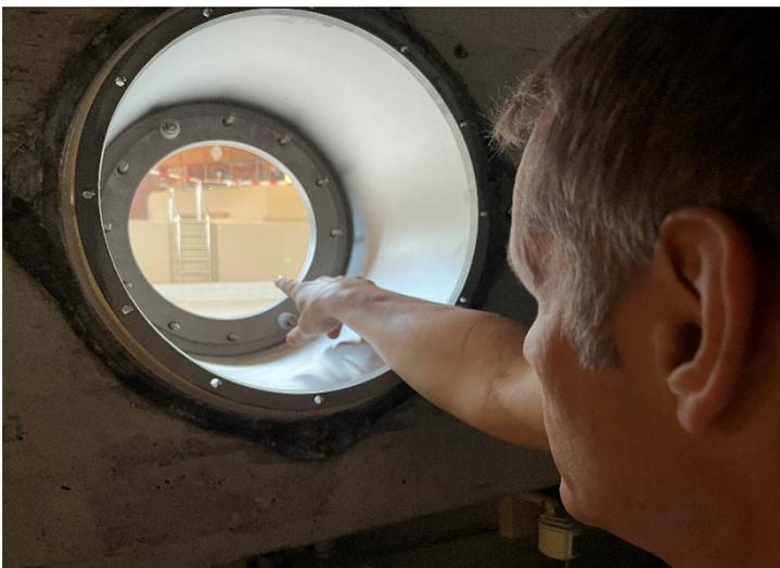
*Die Bullaugen für die Unterwasserleuchten werden neu von innen verschraubt.*
