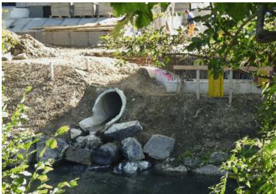
Baustelle der Kanalbrücke Grobenmoos – Widerlager Süd (12. September 2011)
