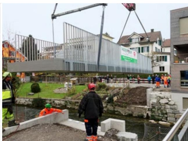
Interessiert wird das Einschweben der Brücke verfolgt. Noch zwei Meter bis zum Widerlager.
