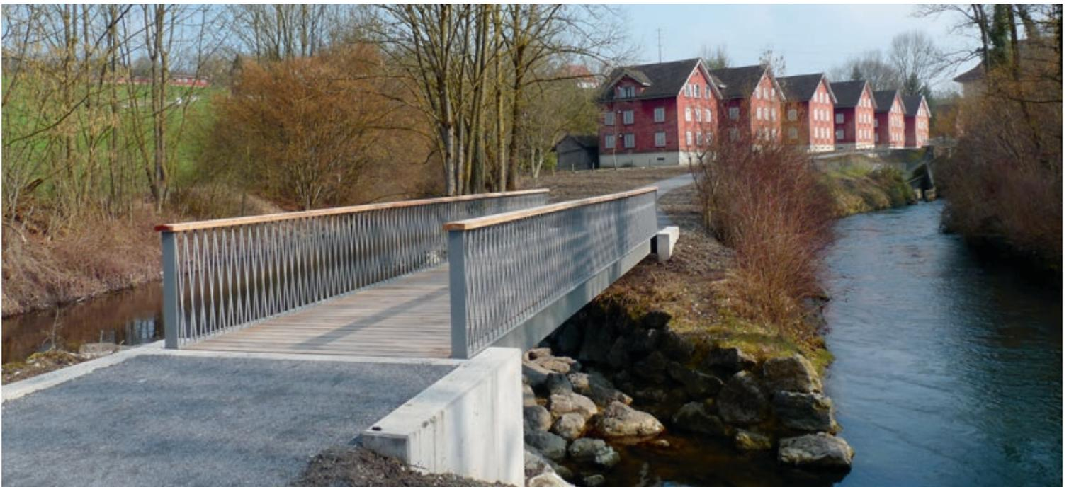
Ebenfalls aus Lärchenholz und Stahl: Die neue Kanalbrücke Furt (Länge 14,4 m, Breite 2,5 m).
